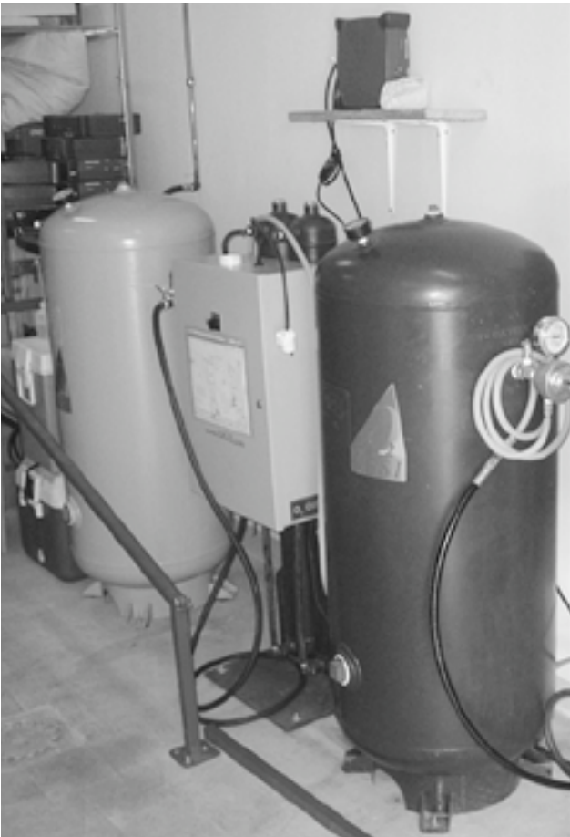
Figure 6 - Petite centrale de production d'O 2 à l'Hôpital de Koulamoutou (Gabon) avec de gauche à droite, le réservoir d'air comprimé, les deux colonnes PSA et le réservoir d'O 2 à basse pression. Matériel de OGSi. Cette centrale suffisante pour un hôpital provincial de 100 lits avec service d'urgence et bloc opératoire a coûté 16 000 euros et, par rapport à l'achat d'O 2 en bouteilles, a été amortie en moins d'un an.
