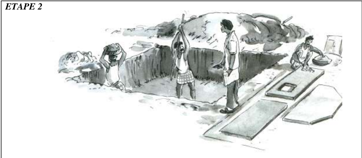
Illustration 2.3.2 Creuser les fondations de l'UTD et de la fosse à cendres
